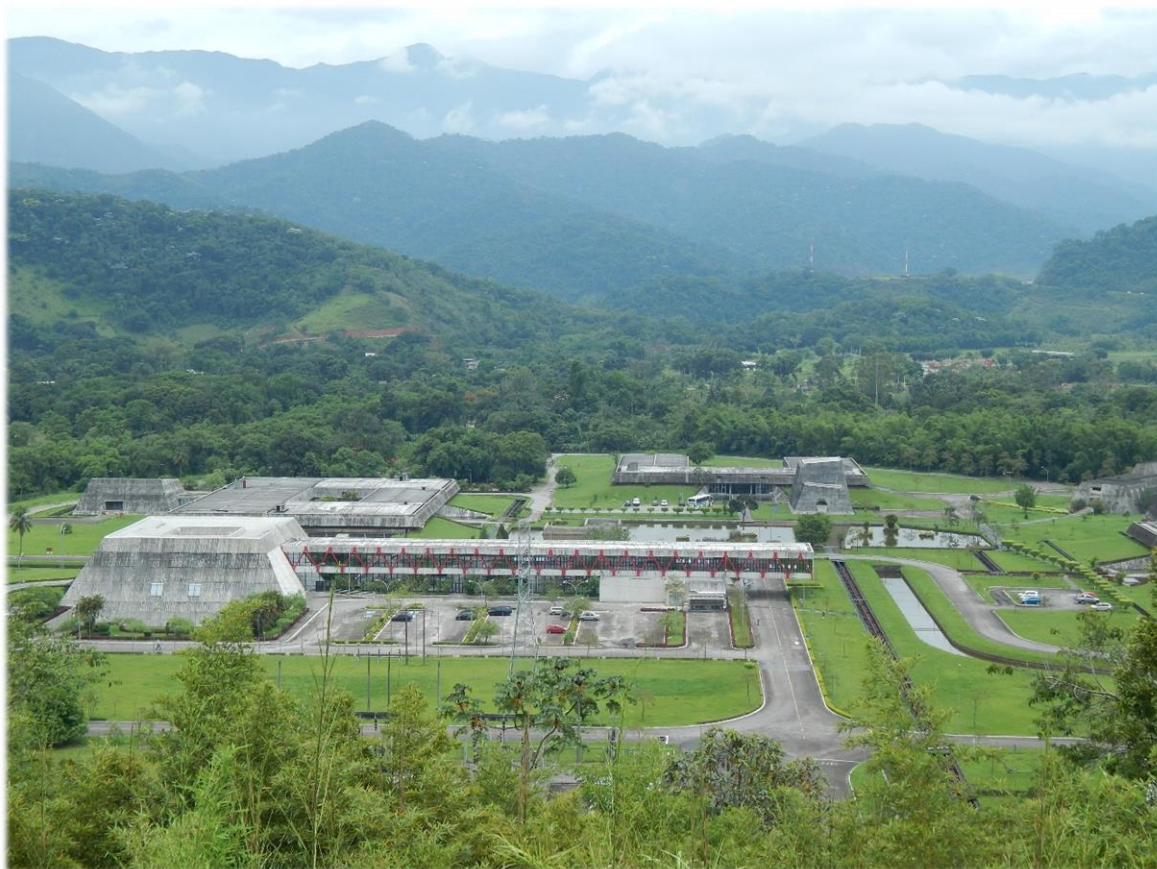
Vista aérea do Prédio 6 (Centro Operacional Administrativo)
